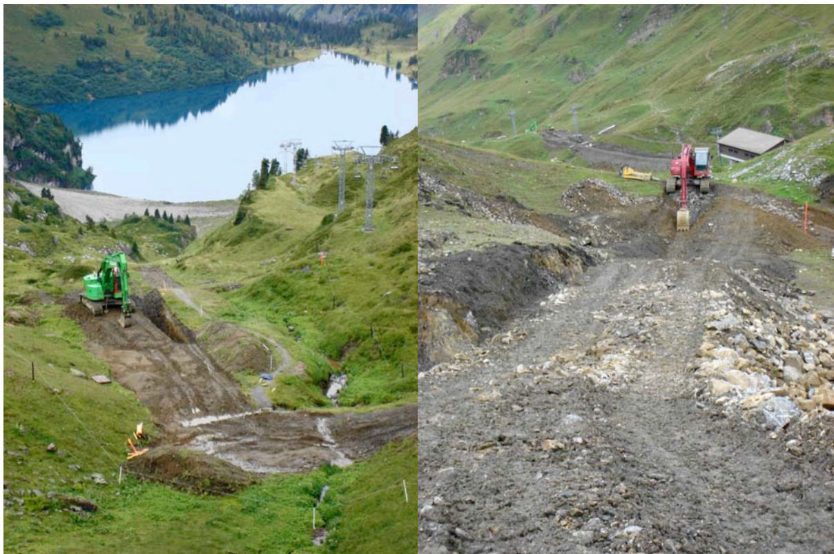
Fotos: Bauarbeiten am Jochpass (August/September 2010)
